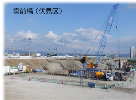
工事中の橋りょう
