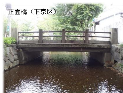
工事に着手した橋りょう
