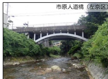
工事に着手した橋りょう
