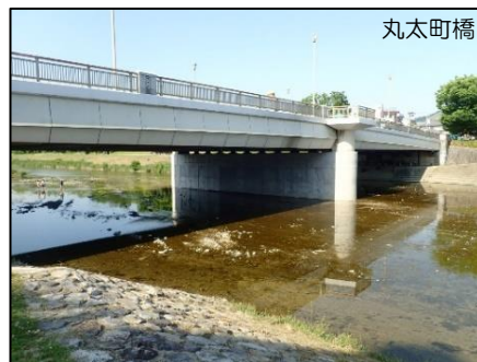
工事が完了した橋りょう
