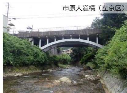
設計が完了した橋りょう
