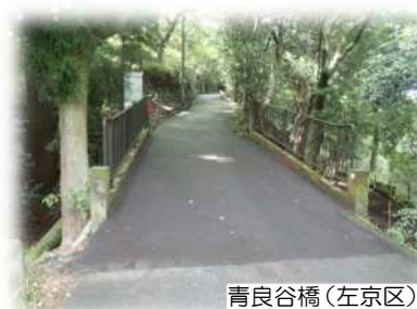
青良谷橋（左京区）
