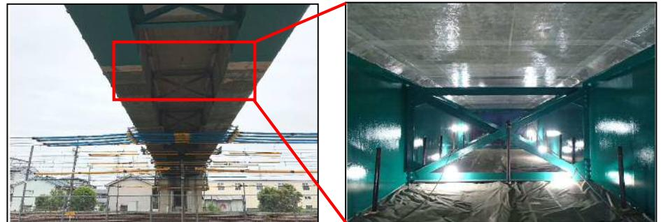
・長寿命化を図るため、劣化した桁の塗装を塗替えました。
