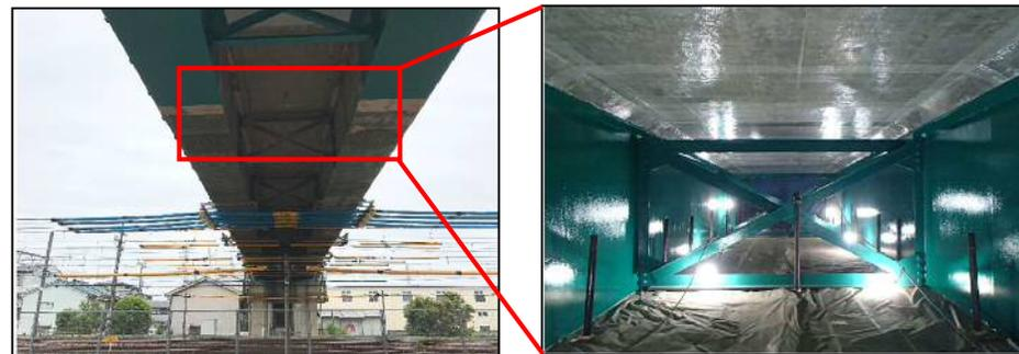
・長寿命化を図るため、劣化した桁の塗装を塗替えました。
