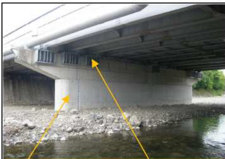
巻立て補強後の橋脚
