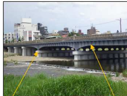
交換した支承
