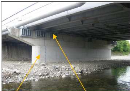
巻立て補強後の橋脚
