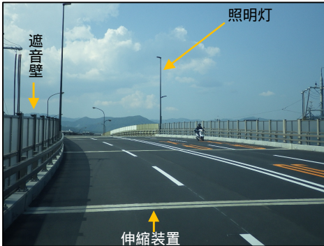
伸縮装置，遮音壁，照明灯を取替え，舗装を新しくしました。
