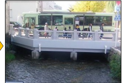
車道部を架け替え、柵をかさ上げしました。
