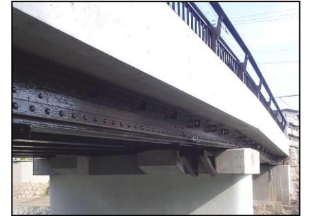
↑柵，床版及び横桁を取替え，舗装を修復しました。
