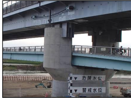
↑耐震補強用の部材を取り付けました。
