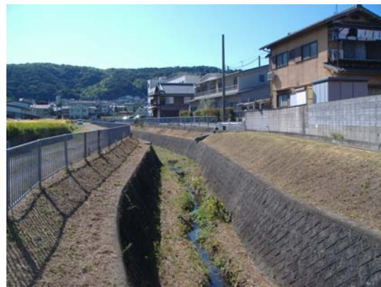
生物多様性に配慮した低水路工法
