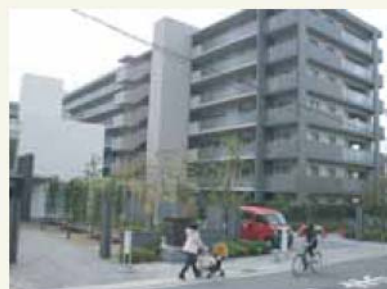
近年建設されたマンション
