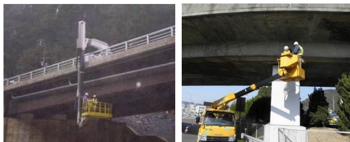
図 4.1 定期点検の様子
