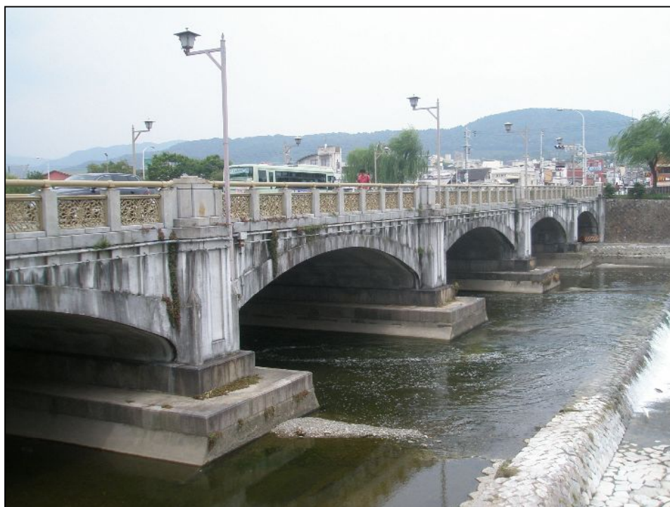
写真：七条大橋（大正2年完成 土木学会選奨土木遺産）
