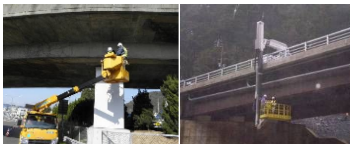
図 4.2 詳細点検の様子
