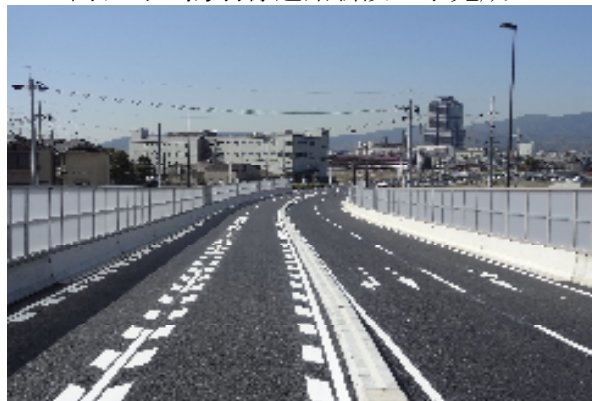
向日町上鳥羽線道路新設工事完成
