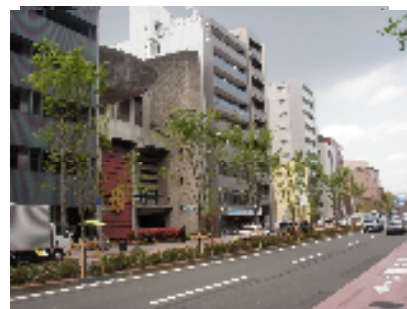
烏丸通完成区間
