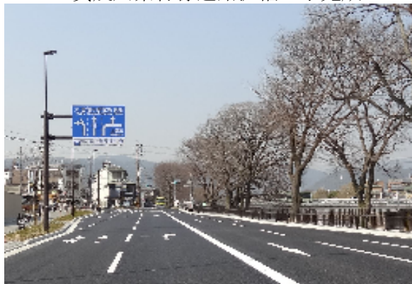
賀茂川紫竹線道路拡幅工事完成
