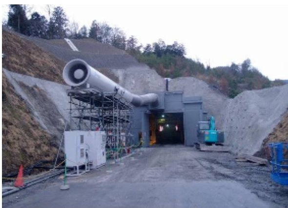
二ノ瀬バイパス トンネル南側坑口付近
