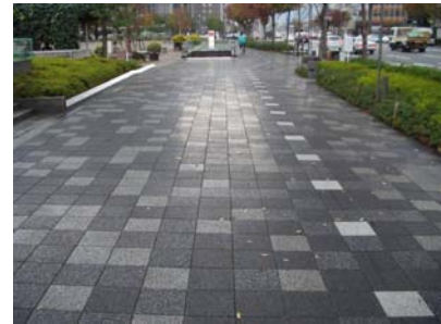
透水性舗装の事例 (御池通歩道)
