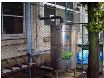
市立小学校に設置された 雨水タンク
