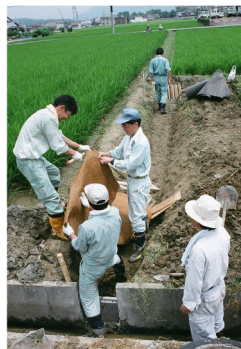
田んぼと排水路を結ぶ魚道（巨椋池地区のワークショップ活動）
