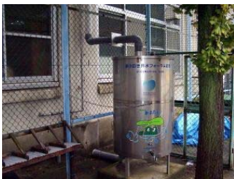
市立小学校に設置された 雨水タンク
