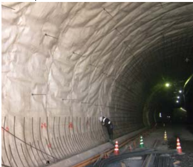
防水シート施工状況
