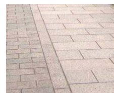
歩道と車道で同系の舗装材 で異なるサイズを用いて いる例
