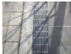
異なるサイズの舗装材の目地 を揃えている例
