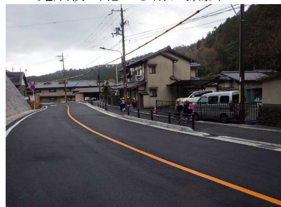
完成後（北から南に撮影）
