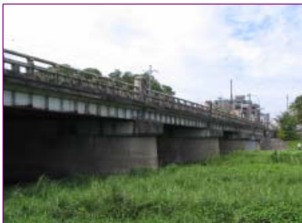
工事前の北大路橋
