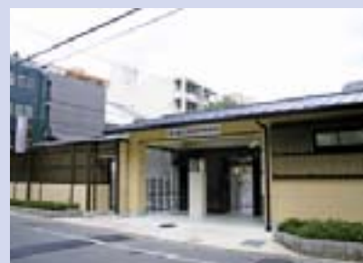
富小路六角自転車駐車場
