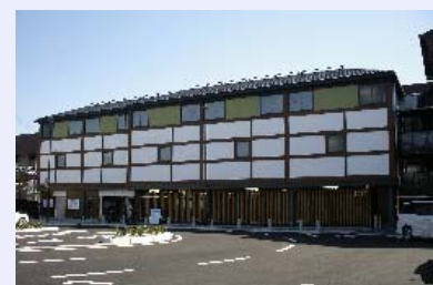
嵯峨嵐山駅自転車等駐車場
