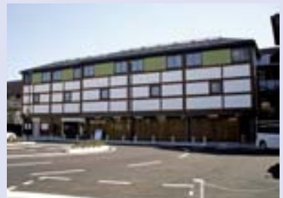
嵯峨嵐山駅自転車等駐車場
