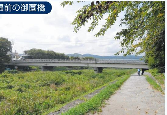
昭和10年8月11日、鴨川の橋の大半(20橋)が流される大水害が発生し、御園橋も流失したが、水害の2年後の昭和12年12月に架け替えられた。御園橋は、水害後初めて鴨川にかけられた鉄の橋であった。
