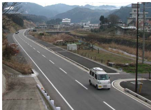
整備後（バイパス）
