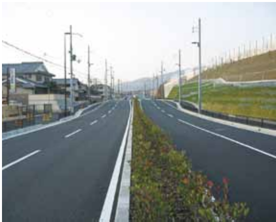
整備後(平成25年3月撮影)
