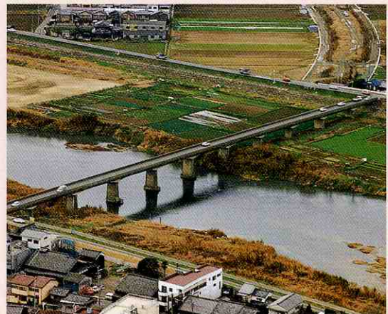
旧橋—昭和14年架橋 橋長238m 幅員5.5m
