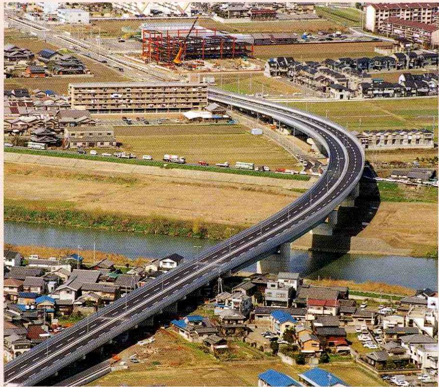
新橋—平成9年4月架橋 橋長742m 幅員16m
