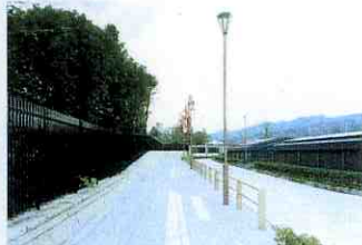
▲歩道舗装：自然と調和する御影石
