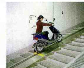
▲出入口通路：サイクルコンベヤーを設置
