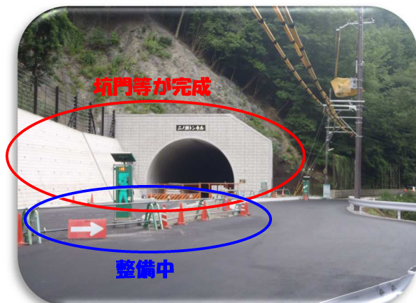
現在の状況(トンネル北側) 平成26年7月
