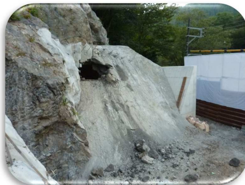
貫通時(トンネル北側) 平成25年10月
