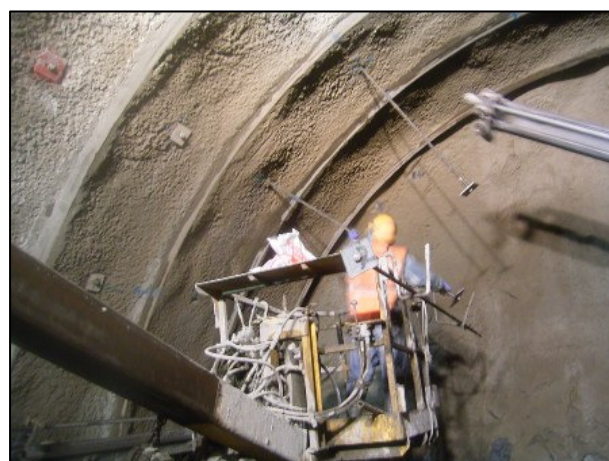
ロックボルト取り付け
