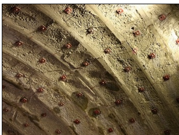
ロックボルト取り付け完了
