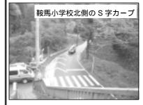
バイパスを計画するにあたり、当初私たちは自然改変を極力抑えるために、小学校前の現道路を拡幅整備する案を検討しました。上の図をご覧ください。現道路幅が狭いために、<u>梶取橋、小学校のいずれも大規模な改修</u>が必要になり、また、小学校の直ぐ北側がきつい S 字カーブなので、基準を守るために新しい橋を2つ設置することになります。工事の面では、現道路の改良と橋の設置のために、長期間の交通への影響が発生します。
