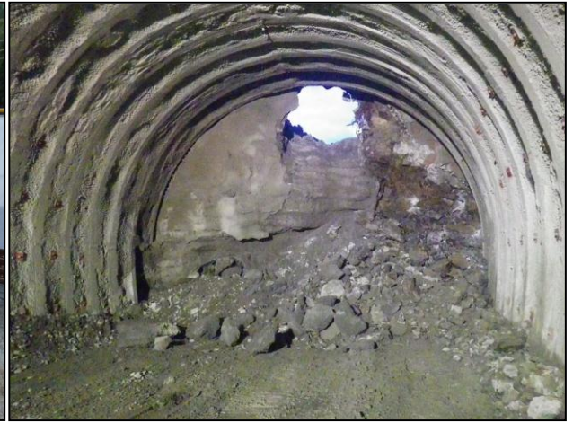
(トンネル内側から)
