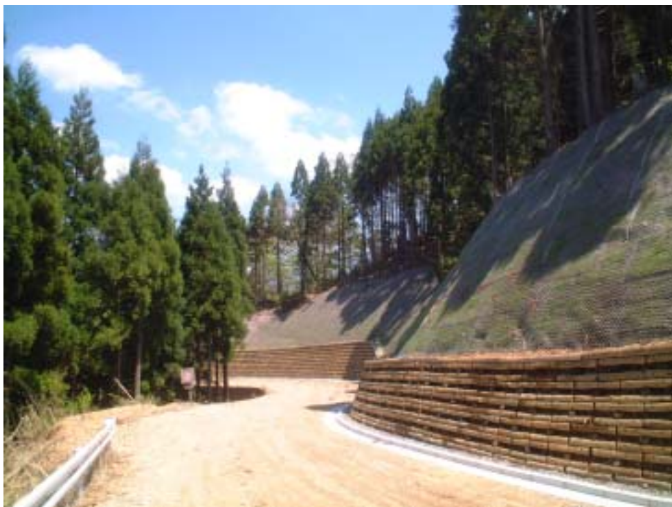
林道久多尾越線改良工事（左京区花脊原地町地内）
