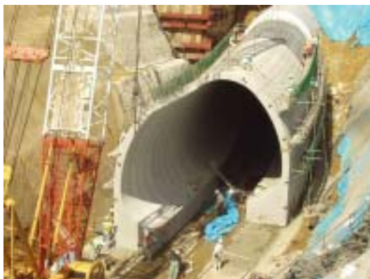
（プレキャストトンネル）
