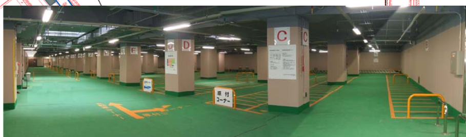
地下駐輪場風景
