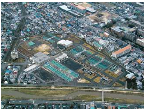
【図 1.2.3 の 2】 松ヶ崎浄水場
