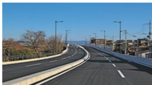
第2工区 第1工区側から北を望む (令和2年3月撮影)
