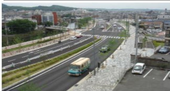
第1工区 鴨川東ランプから南を望む (平成27年1月撮影)
