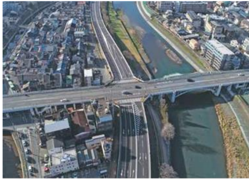
九条跨線橋に繋げた新たな橋りょう
