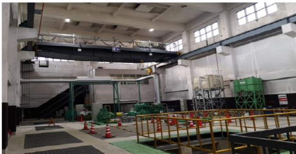
（小栗栖排水機場 実地監査にて撮影）
