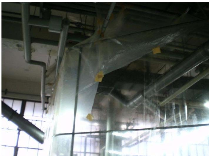
(写真①) は、1階天井の一部の老朽化が著しく、塗装等の一部が剥離し落下することがあるため、カバーをかけているものである。応急的措置にて対応しているものの、改修等の抜本的な対策を検討する必要がある
