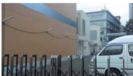
変電所建物(中より奥の建物)
