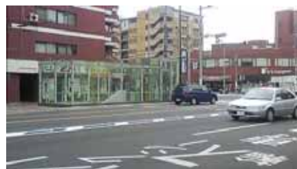
西大路東側シールドエレベーター
