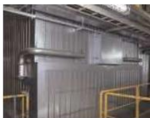
排ガス処理設備の例（南部CC）
