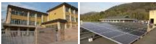
京都市立春日丘中学校（発電出力 44 kW）
