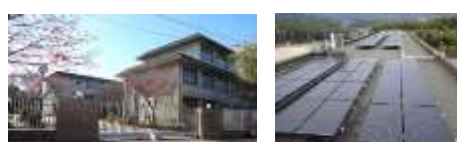
京都市立大原野中学校（発電出力 60 kW）
