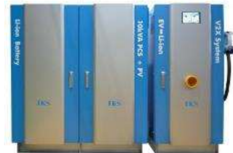
みやこめっせに導入された SiC パワーデバイス搭載の高効率蓄電池
