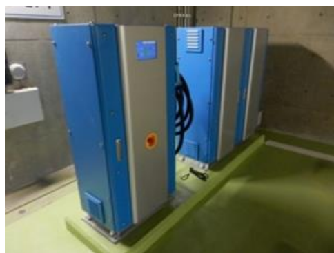
みやこめっせに導入した SiC パワーデバイス搭載蓄電システム
