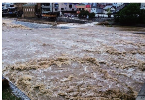
2013年の台風18号 による鴨川増水の状況
