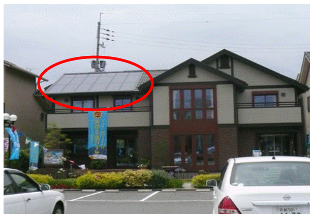
設置例（赤丸が太陽光パネル）
