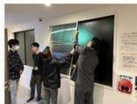
組み立ててサッシにはめ込みます（この作業がなかなか大変だったそう）。
