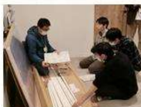
そして断熱材、枠組をカット。
