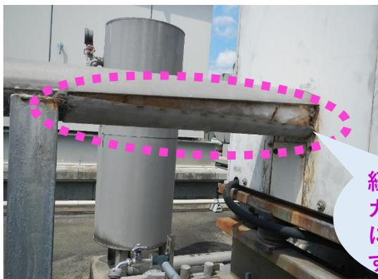
経年劣化により、カバーの継ぎ目に割れが生じやすいです。
