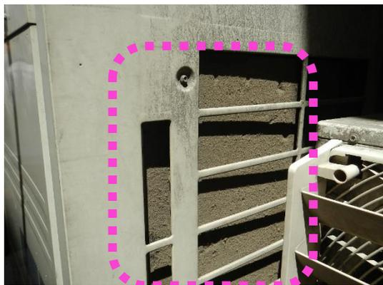
フィン、室外機の薄い金属板が多数並んでいる部分で、エアコンの熱交換を行う大切な場所です。
