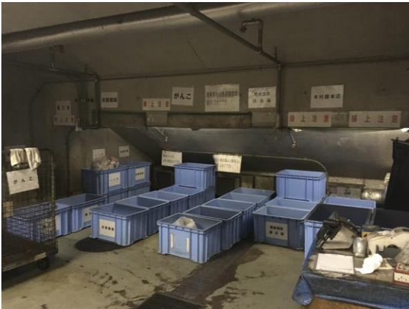
ごみ処理室の写真①
